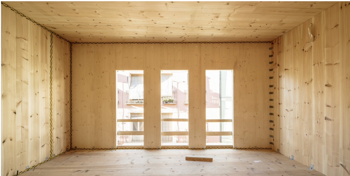
Edificio de viviendas 15 Buenavista, en Lavapiés, durante su construcción. © Adrià Goula
